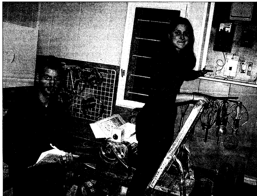
Stéphane Chatelin et Sophie Gabarrot, d'Enercoop Ardennes, posent un appareil de mesure.
